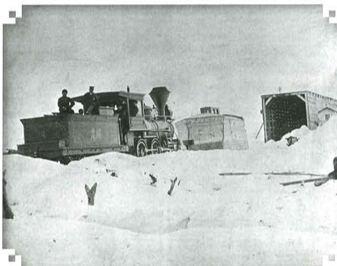
機関車弁慶号に雪払車を付け除雪走行（明治15年／1882年）【北大北方資料室】
