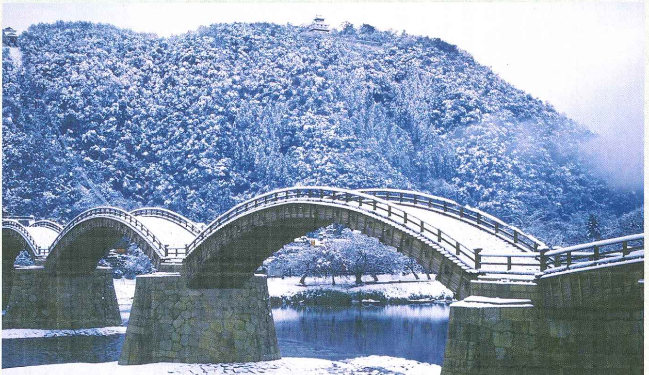
山口県岩国市「錦帯橋」
